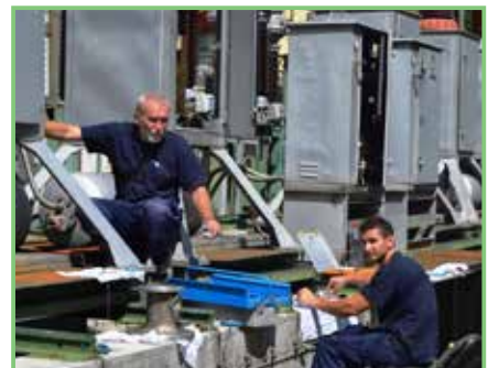
Remont razvodnog postrojenja
