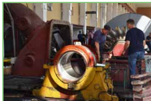
HE „Perućica“: Kapitalni remont generatora br. 6
