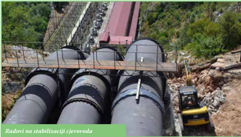
Antikorozivna zaštita cjevovoda
