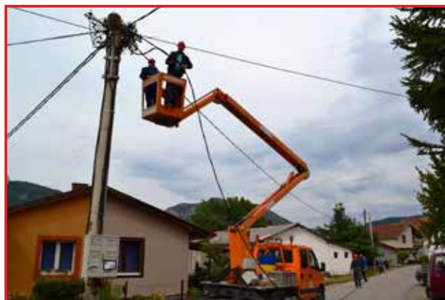
Ekipa firme Mezon iz Danilovgrada ugrađuje nova brojila u dijelu traforeona „Šaćina Bara“.
