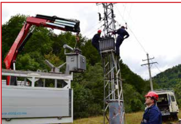
Monteri, Vojo Veljić i Mirko Jočić (na stubu), Ergin Adrović i rukovalac mašinom, Miodrag Radevi, mijenjaju transformator iz kojeg je 07. septembra ukradeno trafo ulje.
