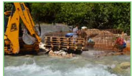
Rekonstrukcija vodozahvata rastavne vode
